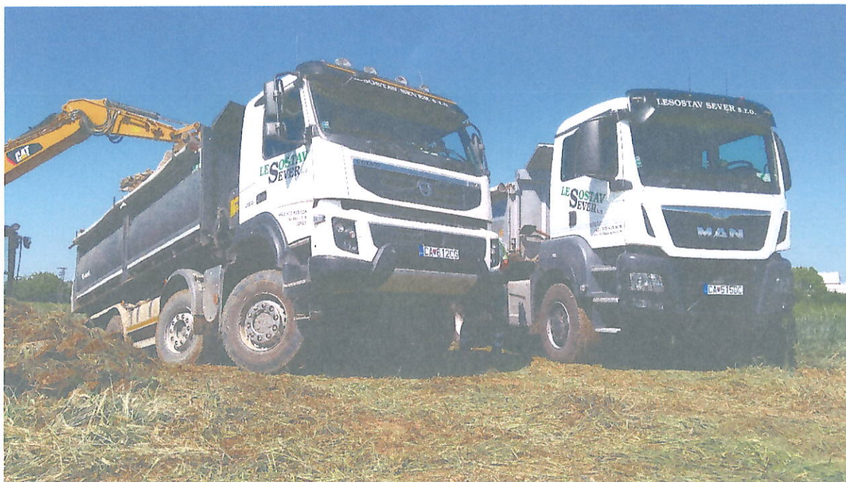
9. Rekonštrukcia vedenia 1 x 110kV V 8761 Trnava
