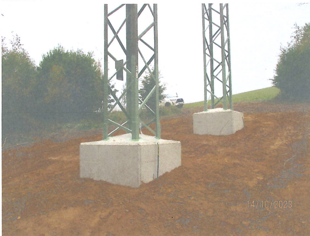
5. Oprava betónových základov stožiarov Raječek – Břidličná r. 2023
