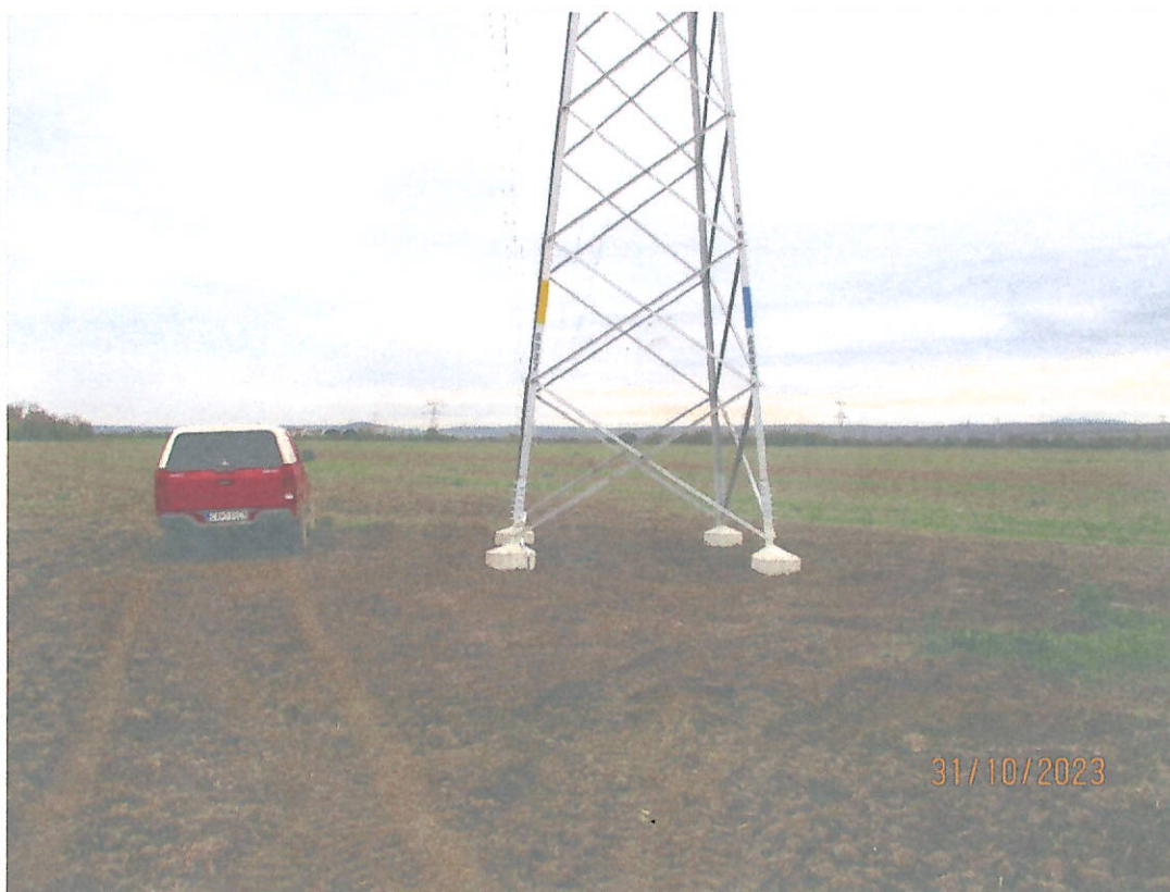
7. Oprava betónových základov stožiarov vedenia 2 x 110 kV Vôľa – Ložín
