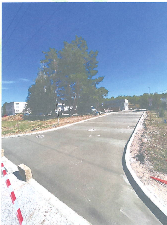
8. Rekonštrukcia spevnených plôch SW13841 Prievidza - Vápenická, r. 2022
