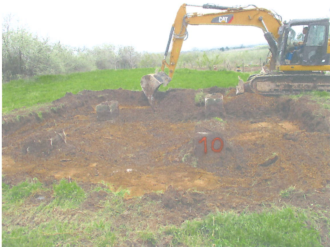
1. Demontáž vedenia V 247 Križovany - Bystričany r. 2023
