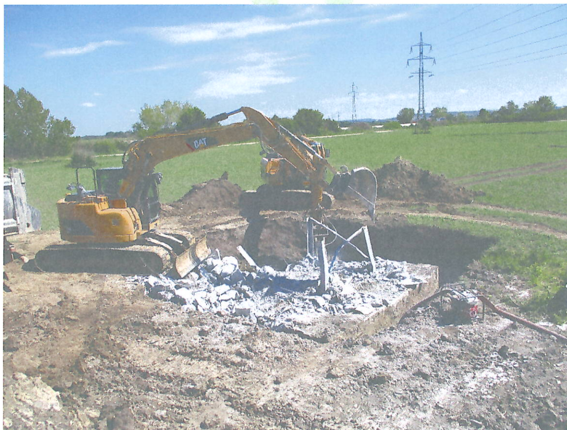
2. Demontáž vedenia V 247 Križovany - Bystričany r. 2023
