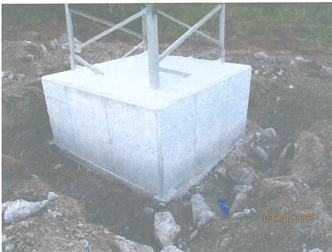
6. Oprava betónových základov stožiarov Raječek – Břidličná r. 2023
