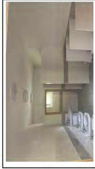
Prístavba MŠ Stredné Plachtince, r. 2023
