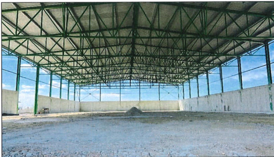
Výstavba základových konštrukcií a oporného múru pre sklad v obci Vlčany
