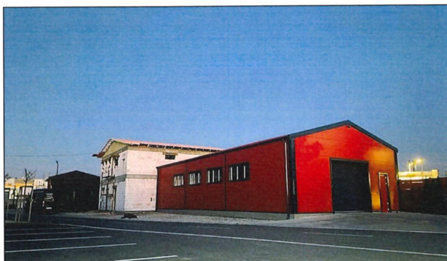
Výstavba firmy IP BUILD s.r.o.
