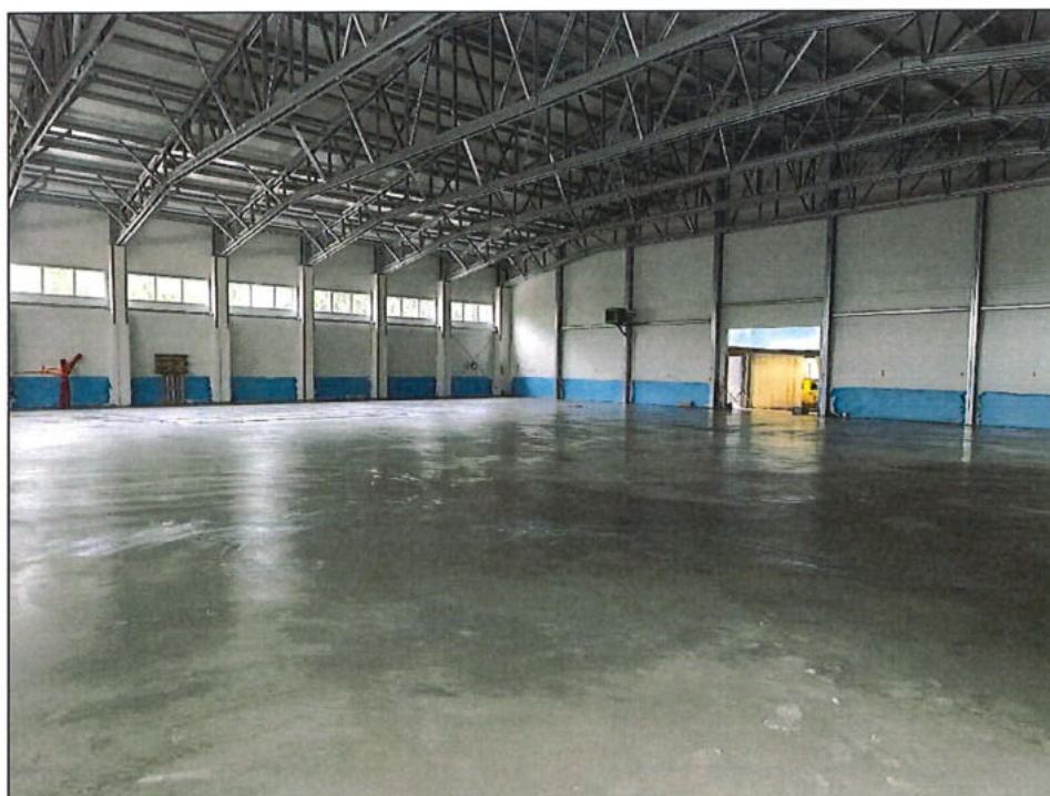
Výstavba haly pre strojársku firmu v Nových Zámkoch
