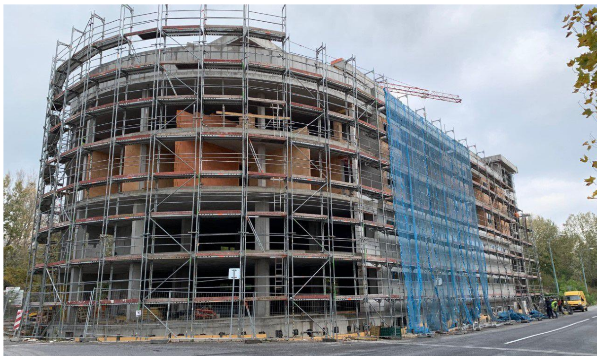
Zateplenie novostavby Betliarska 12, Bratislava
