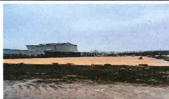
Zhotovenie spevnených plôch, kompletná betonáž - PACT Šurany, 2024
