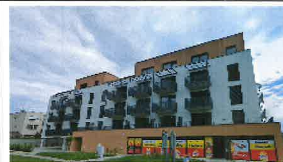
Výstavba BD Ďurčanského - bytové domy Nitra, 2023
