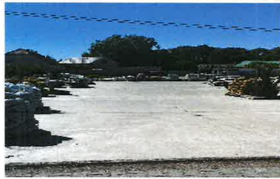
Zhotovenie spevnených plôch Juhokameň s.r.o., Nové Zámky, 2024
