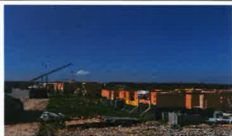
RD Lužianky Nitra, 2025 Výstavba 14 ks dvojdomov
