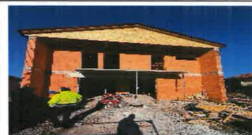
Výstavba polyfunkčnej budovy Okoč, 2025
