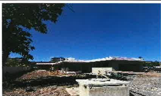
Výstavba SOHO IV, Nové Zámky, 2024 Luxusný bungalov
