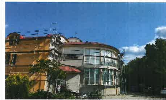
HOSPIC Palárikovo - Rekonštrukcia vonkajšej fasády, výmena okien, 2024
