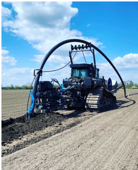
Pluhovanie káblov a potrubí
