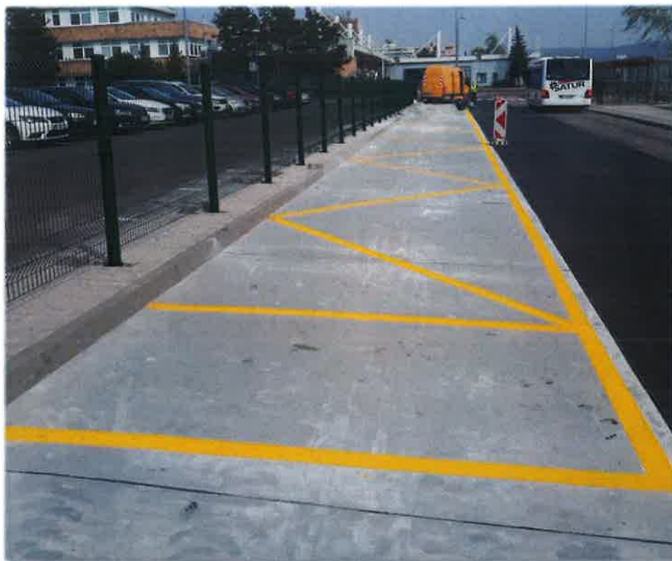
Devínska Nová Ves – kompletne zhotovenie spevnených plôch
