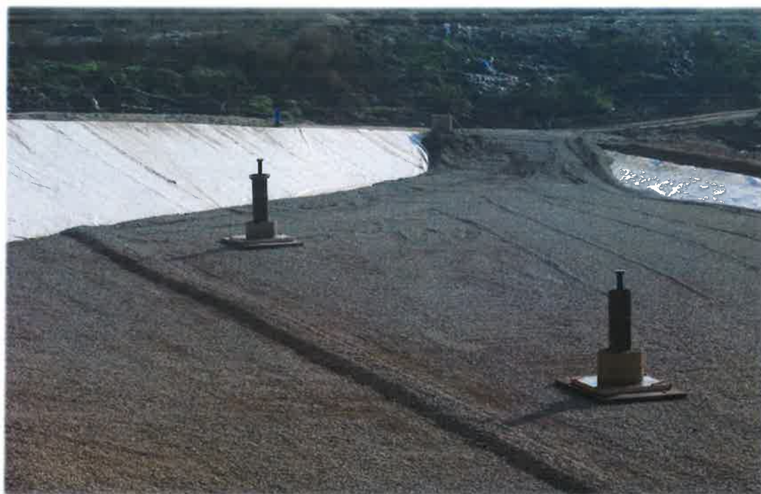
BOJNÁ – skládka odpadov, časť C – 2. Etapa
