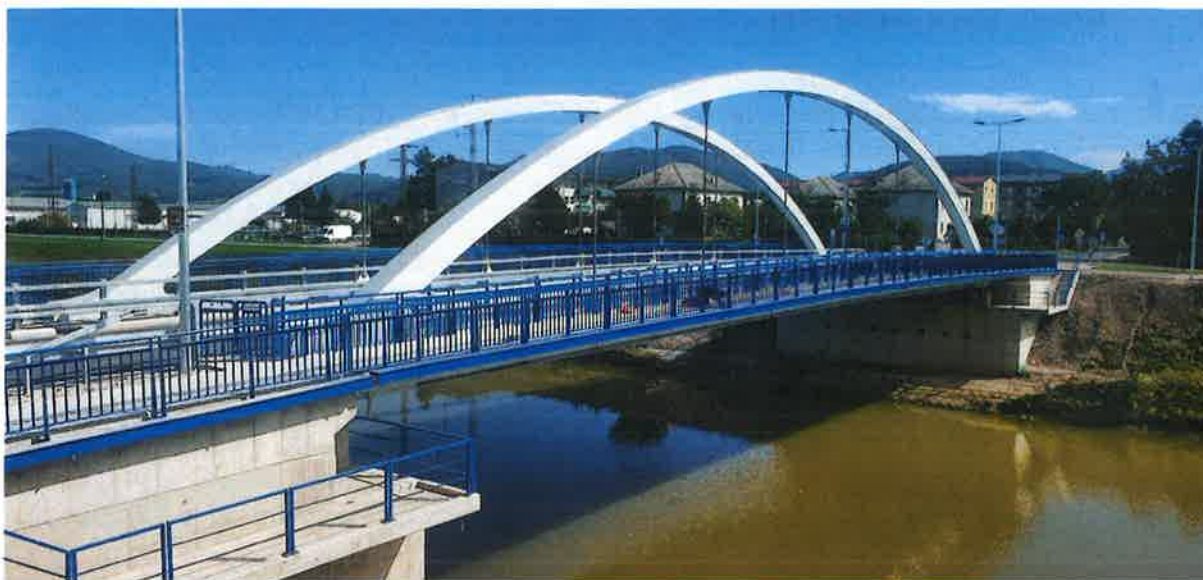
Obr. 2 Sanácia starého mostného objektu a realizácia výstavby nového mostného objektu cez Vážsky kanál v Ilave
