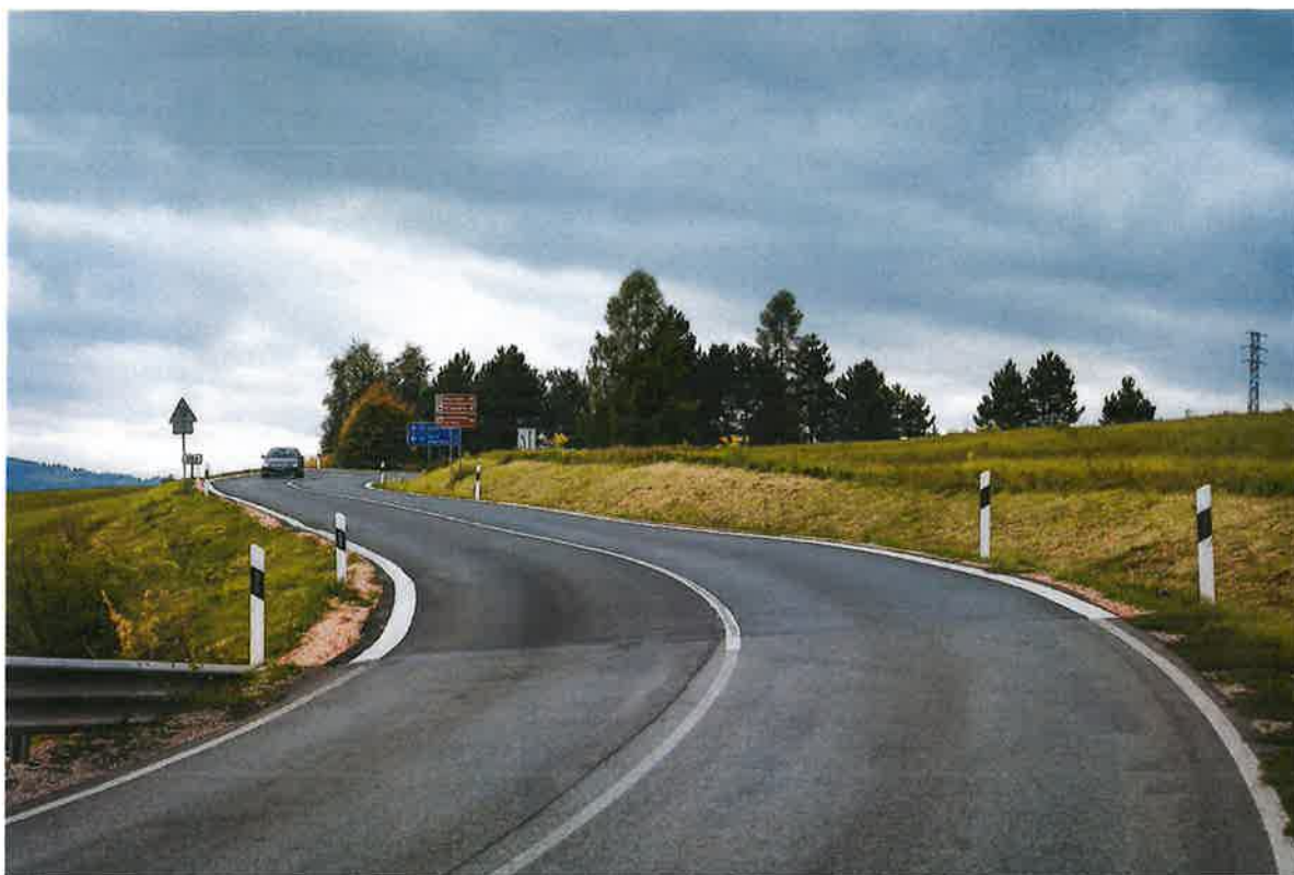
Obr. 4 Stavebné úpravy cesty II/533 Gemerská Poloma-SNV-Harichovce-D1
