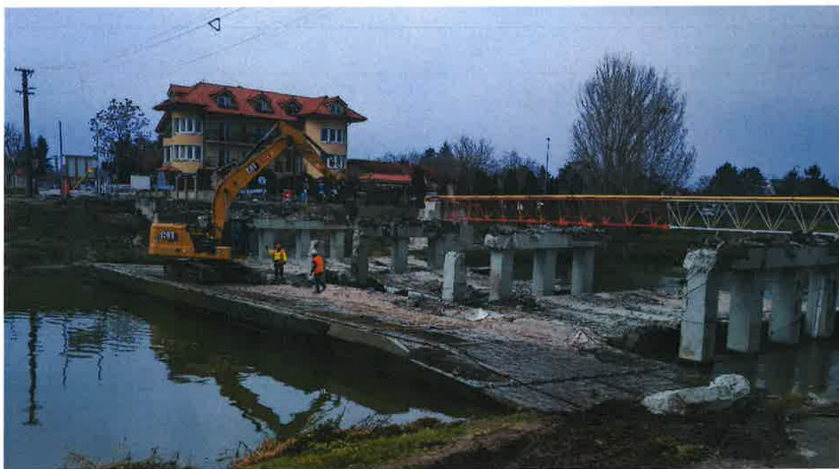
Obr. 1 Demolácia mosta č. 572-003 na Hradskej ulici cez Malý Dunaj vo Vrakuni
