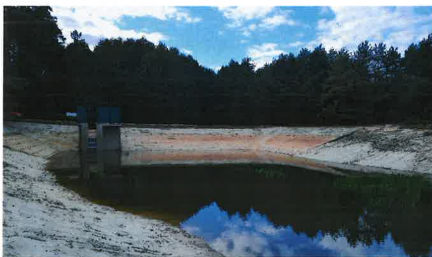
Obr. 7 Vodná stavba Bulkovec II. a III. Rekonštrukcia
