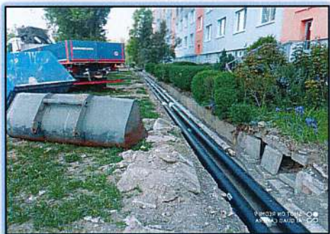
2023 MeT Šaľa – rekonštrukcia rozvodov tepla
