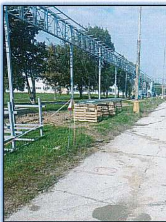
Rekonštrukciu nadzemných káblových trás VN a NN rozvodu – CV5, Časť: Zmena napájania pre PTS Cirkulačná vodáreň
