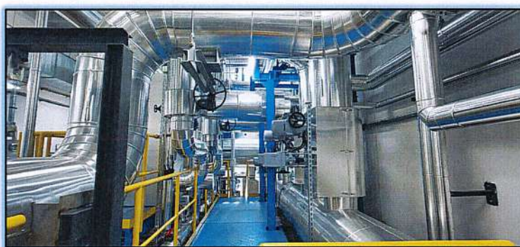
2023 KOSIT Košice kotel K1 rekonštrukcia
