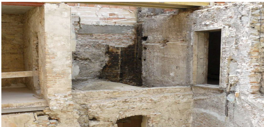
Rekonštrukcia polyfunkčného domu Bratislava
