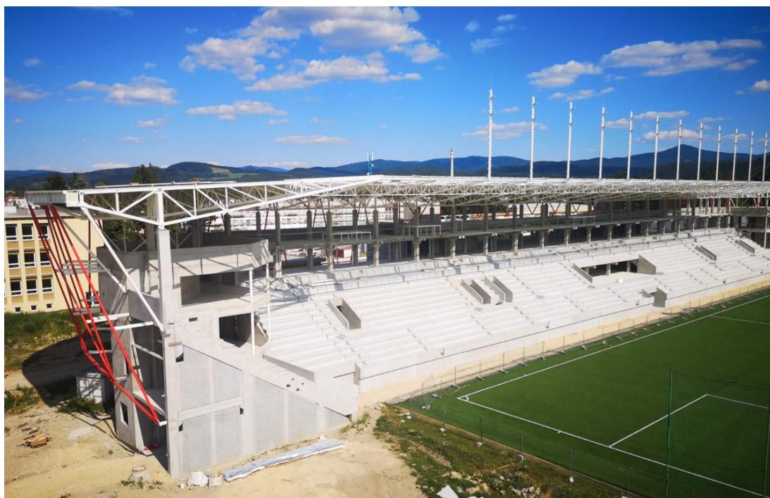
Výstavba futbalového štadióna v Trenčíne.
