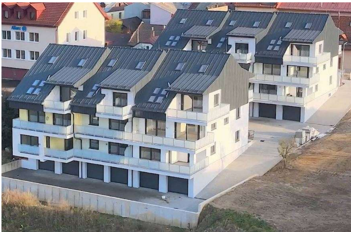
Foto č. 6 – Radové rodinné domy Farbiarska
