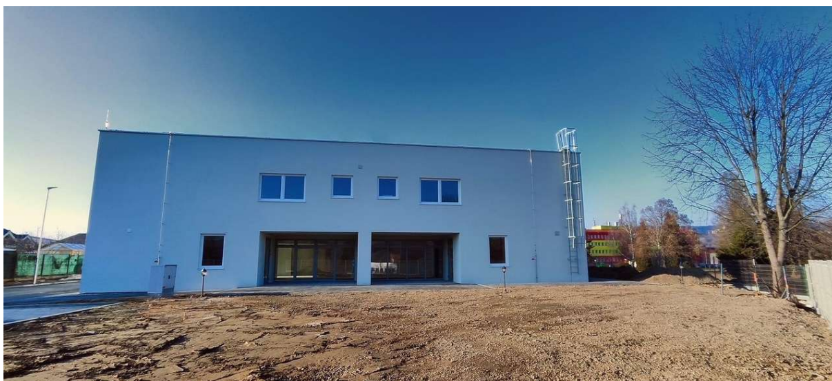
Foto č. 1 - Zmena dokončenej stavby súp. č. 1912 stavebnými úpravami na zariadenie sociálnych služieb Stará Ľubovňa
