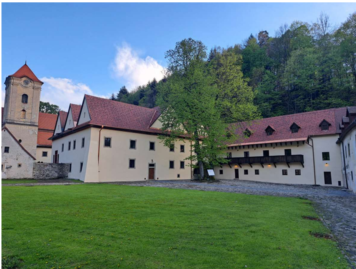
Foto č. 4 – Stavebná obnova exteriérov objektov E & F NKP Kláštor kartuziánov v Červenom Kláštore
