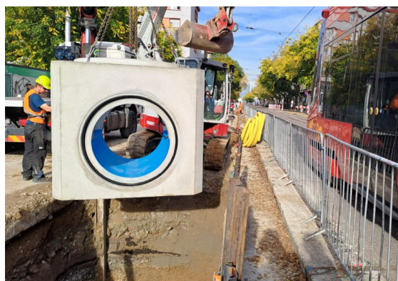
Bratislava, Vajnorská ulica – sanácia verejného vodovodu a verejnej kanalizácie
