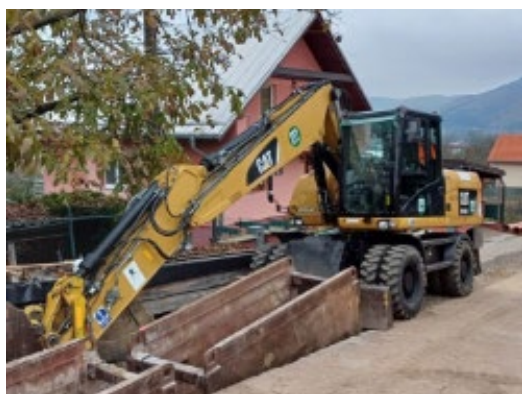
Kónská – Rozšírenie splaškovej kanalizácie
