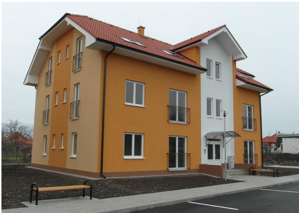
Bytový dom Žitavany.
