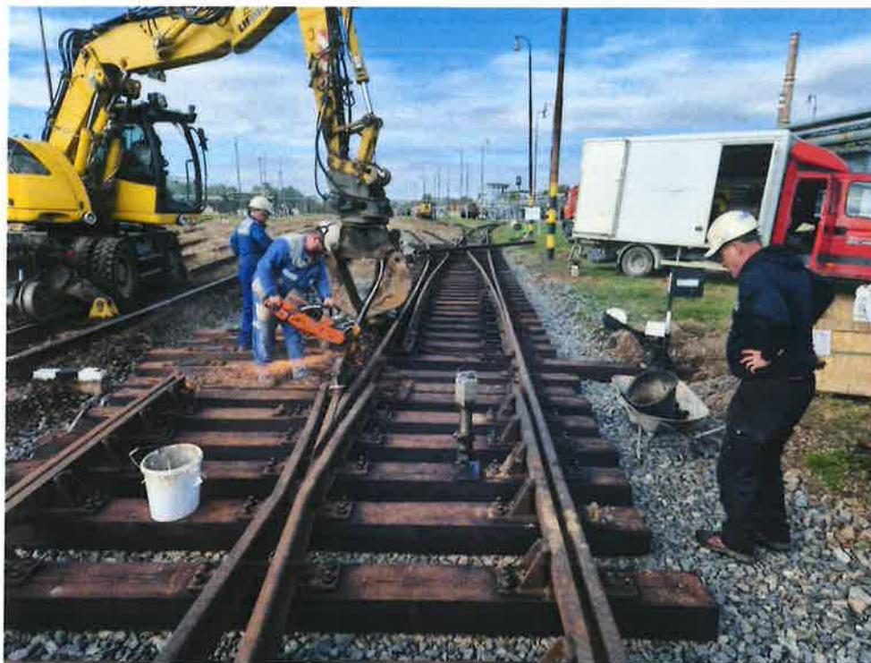
Modernizácia koľajovej trate a výhybiek Vojany
