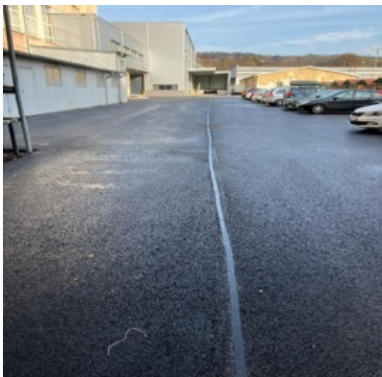
OBUV – ŠPECIÁL, spol. s r.o. – Mesto Bardejov Rekonštrukcia komunikácii v areáli JAS, Bardejov
