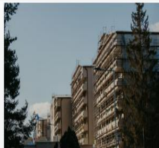
Rekonštrukcia Akadémie ozbrojených síl v Liptovskom Mikuláši
