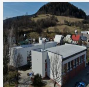
Rekonštrukcia obecného úradu v obci Jasenica
