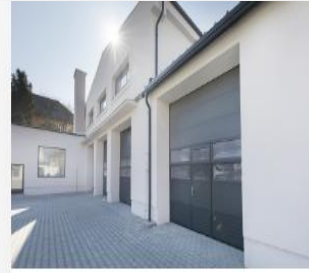
Rekonštrukcia priestorov autoservisu v Rimavskej Sobote
