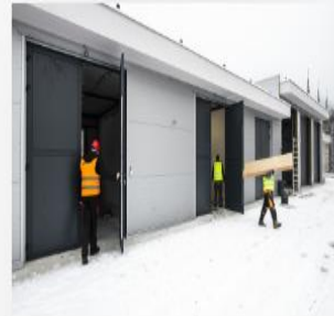
Rozvádzač BTP Horný Hričov
