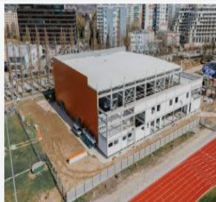
Výstavba športového centra Žilina
