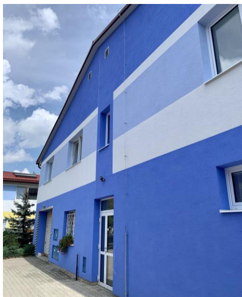
Hala po rekonštrukcii.
