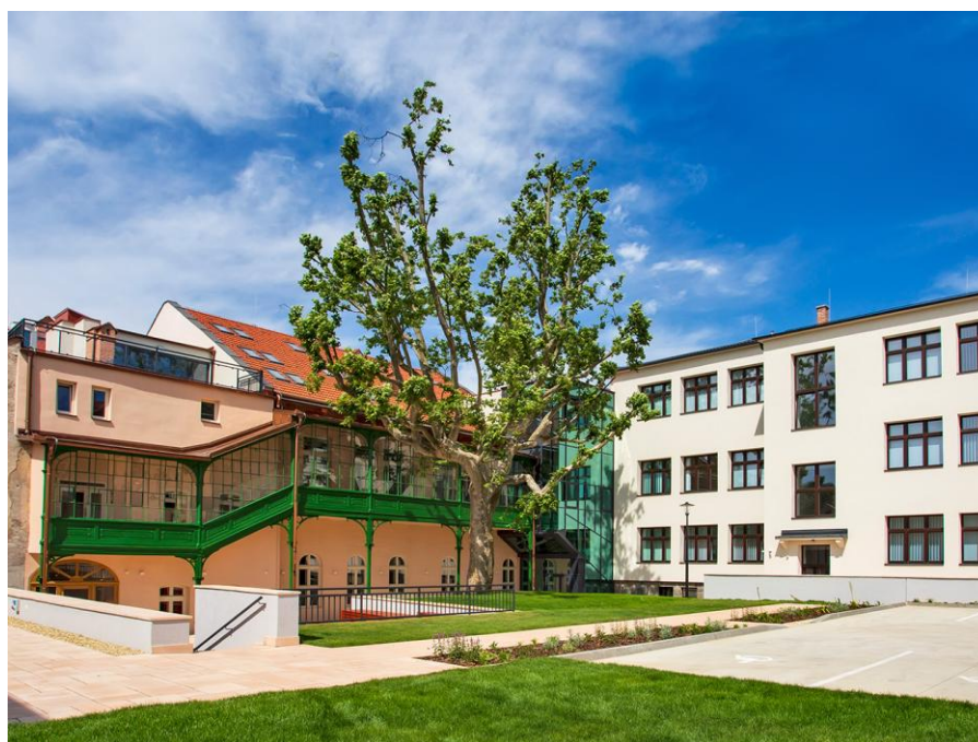
Obnova budovy Krajskej knižnice P.O. Hviezdoslava Prešov
