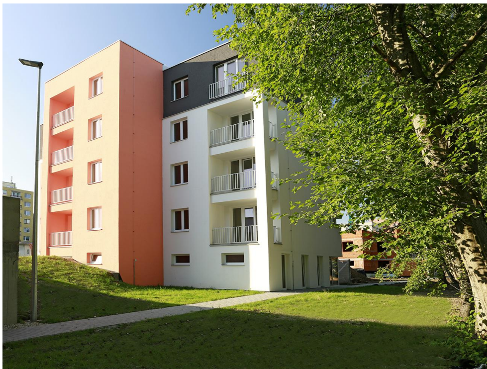
Výstavba bytových domov Bajkalská v Prešove (2022).
