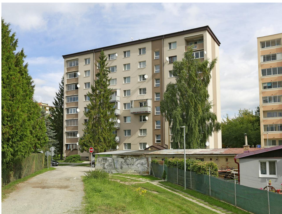
Obnova bytového domu Komenského v Sabinove (2021).
