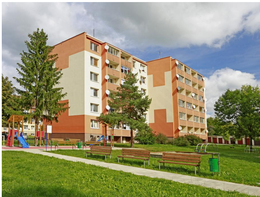
Obnova bytového domu Komenského 30 v Sabinove (2021)
