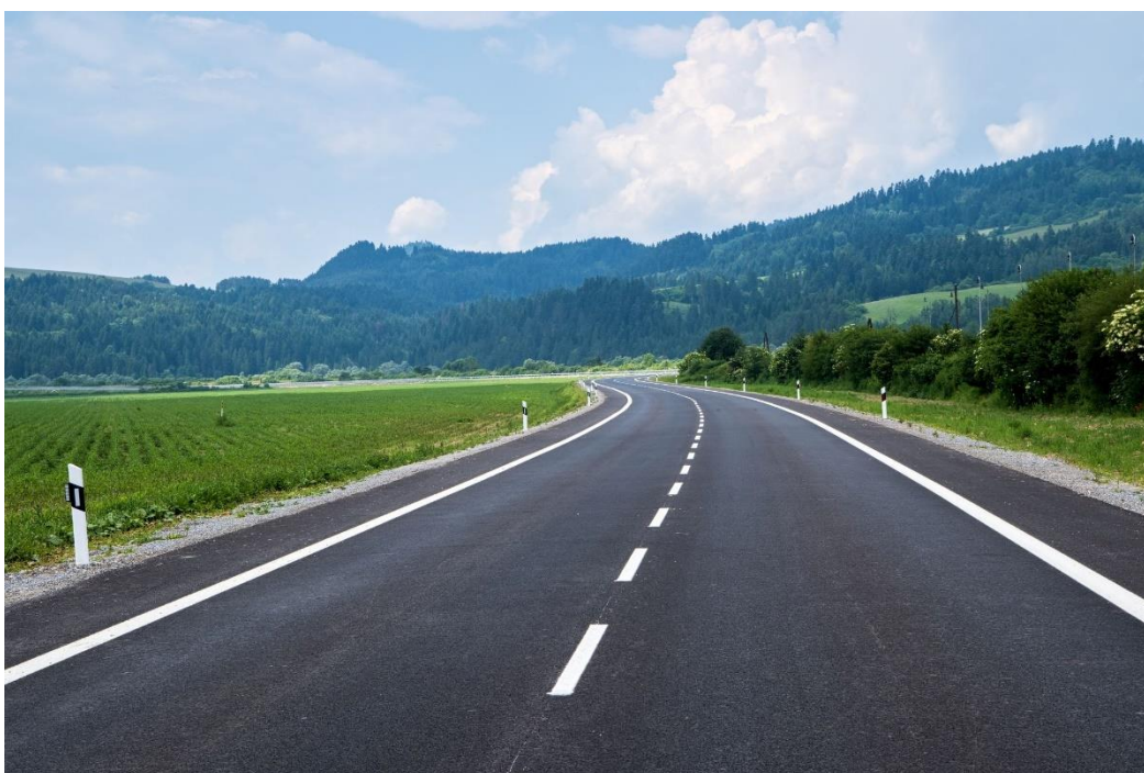
stavba: I/68 Plavnica, preložka cesty
