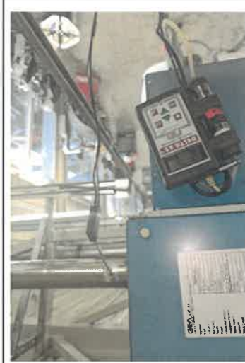
Motor-Car Bratislava, KIA predajňa - odborná prehliadka a skúška plynového zariadenia, r. 2024
