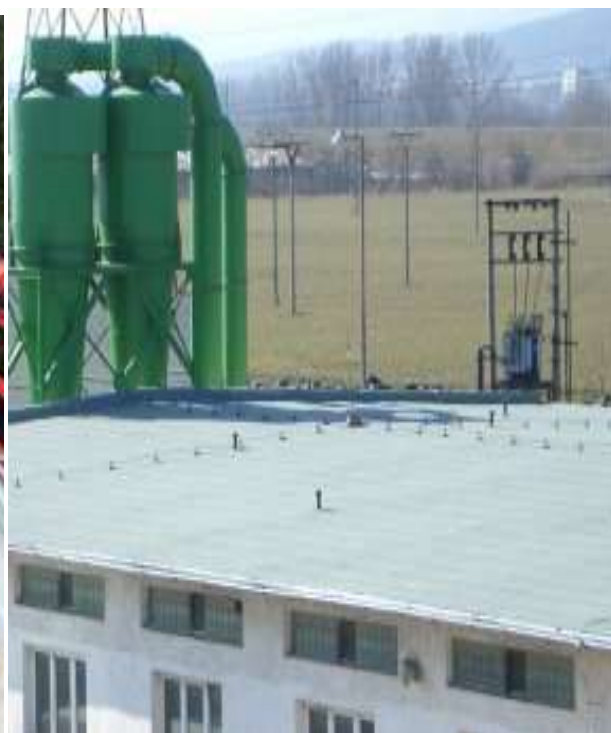
Oprava strechy Beluša
