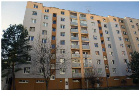
Obr. 3 Komplexná obnova bytového domu – Krasku 667, 668, TREŇČÍN
