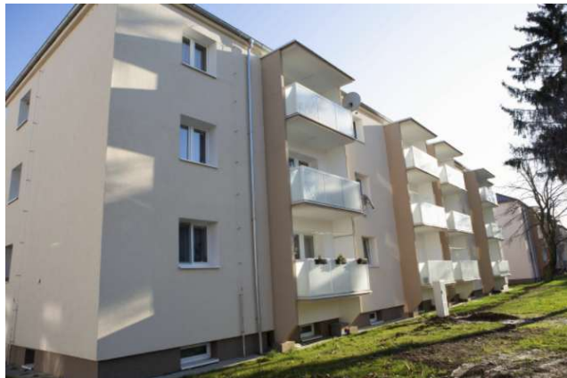
Obr. 5 Komplexná obnova bytového domu – SNP 382/9,10, NOVÉ MESTO NAD VÁHOM
