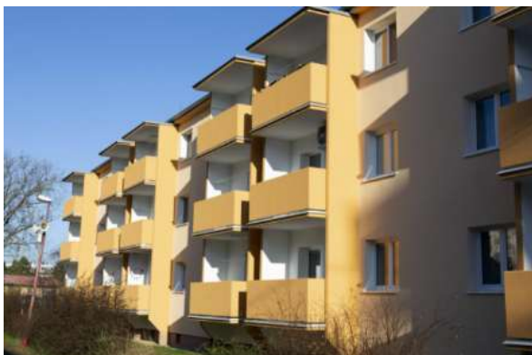
Obr. 1 Komplexná obnova bytového domu – SNP 380, NOVÉ MESTO NAD VÁHOM
