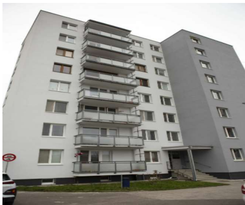
Obr. 4 Komplexná obnova bytového domu – SNP 290/6, VRBOVÉ
