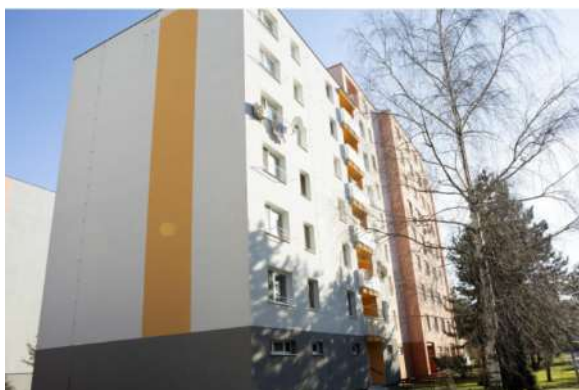
Obr. 2 Komplexná obnova bytového domu – Pádivého 687, 688, TREŇČÍN
