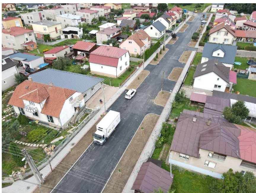
Rekonštrukcia miestnych ciest - Podolíne
