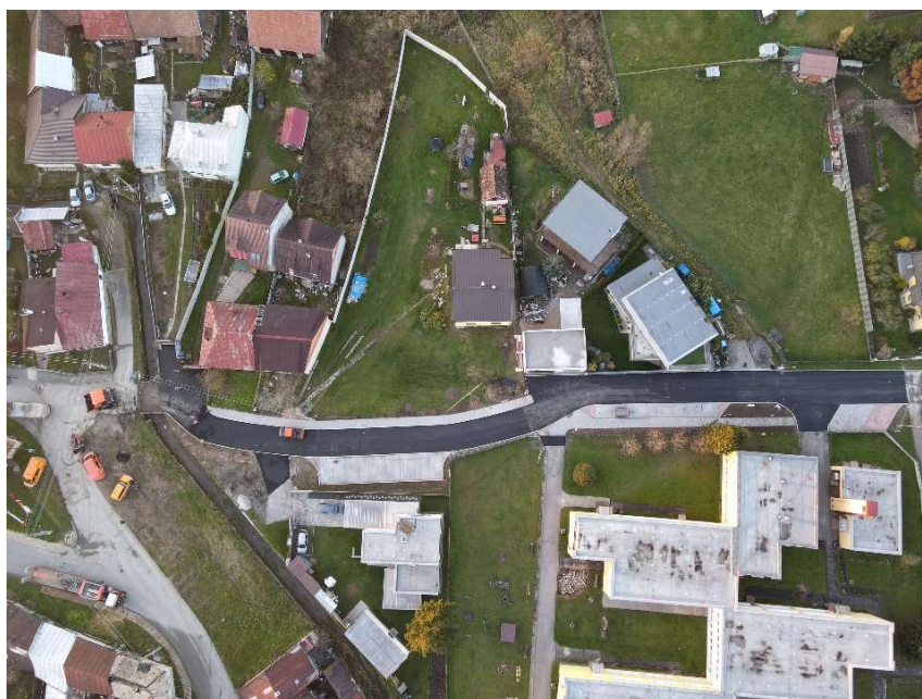
Rekonštrukcia ulice Podolíneč
