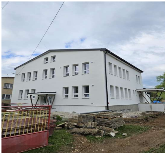
Obr. 2 Zníženie energetickej náročnosti materskej školy Vojňany
