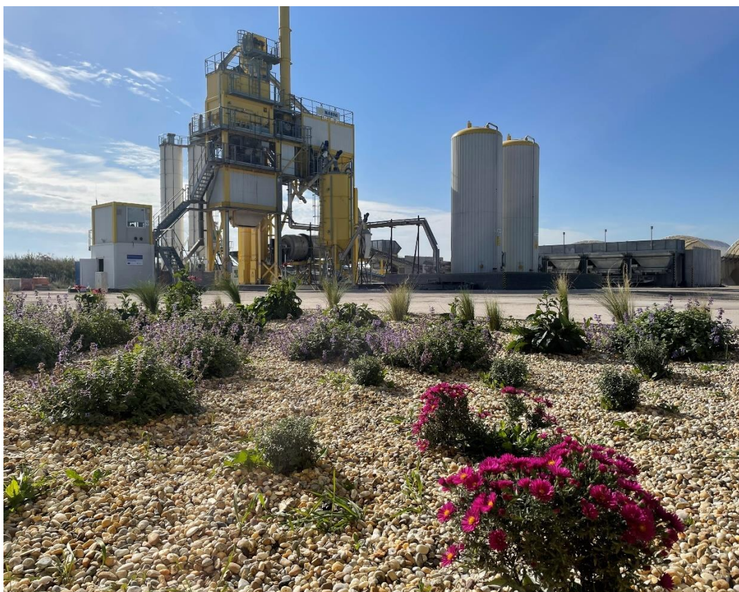
Obaľovacia súprava asfaltových zmesí
