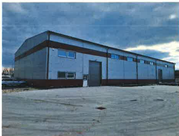
Názov stavby: Výstavba skladovej haly 3, Atrium Invest s.r.o. v Komárne (rok 2023)
