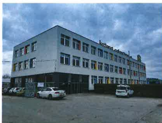
Názov stavby: Zníženie energetickej náročnosti budovy Koženej galantérie v Komárne (rok 2021)
