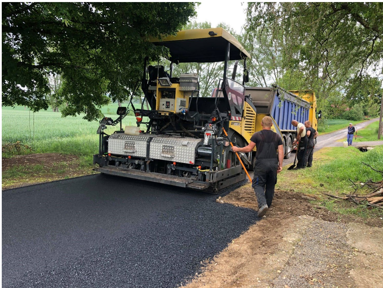
Prístupová cesta k Základnej škole v Obci Lekárovce
