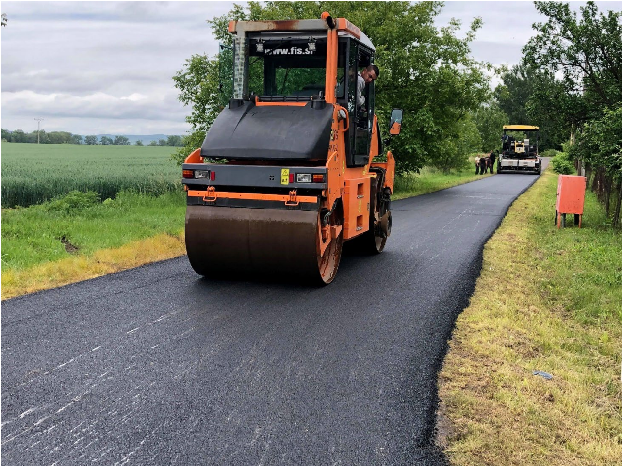
Prístupová cesta k Depu v Čiernej nad Tisou
