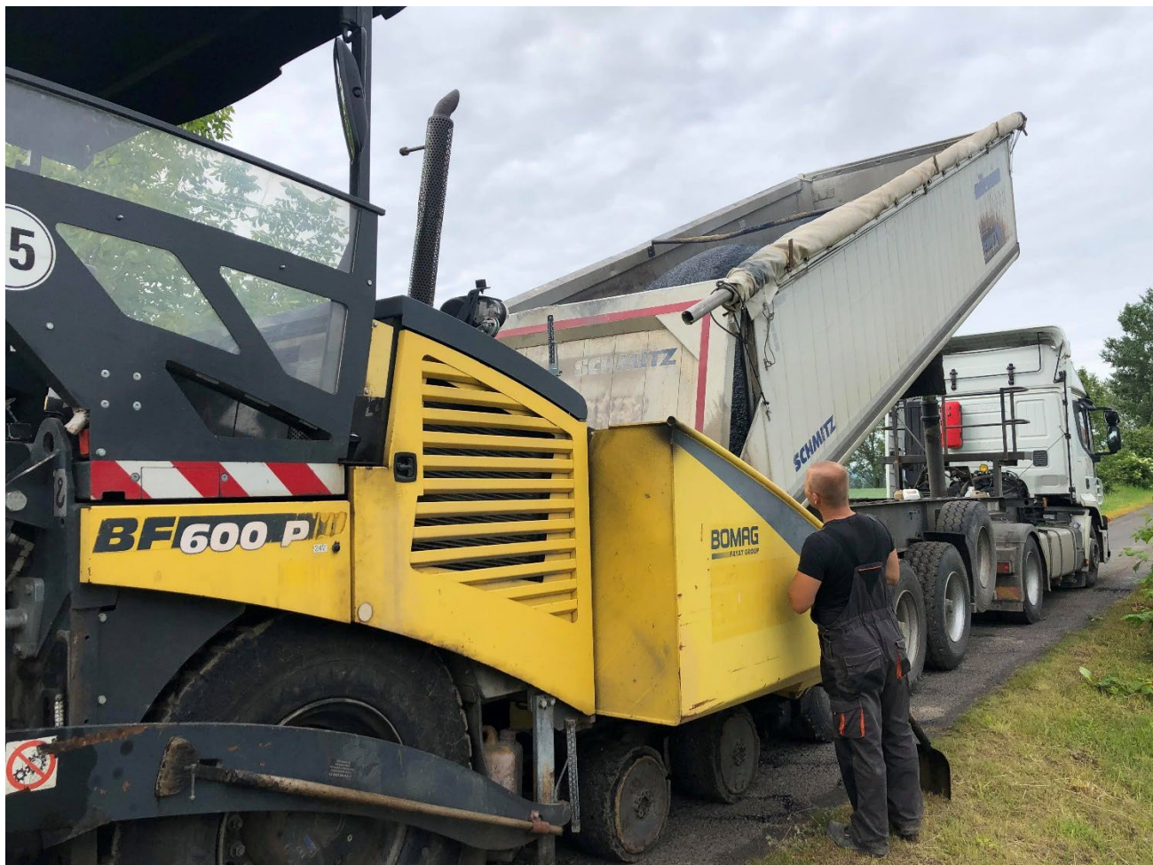
Úsek štátnej cesty III. Triedy Veľký Kamenec
