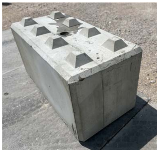
Obrázky: Prefabrikované lego kocky ako využitie odpadového betónu
