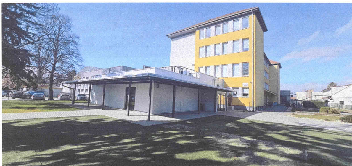
Obr. 4 Prístavba Základnej školy Cíger – elektroinštalačné práce
