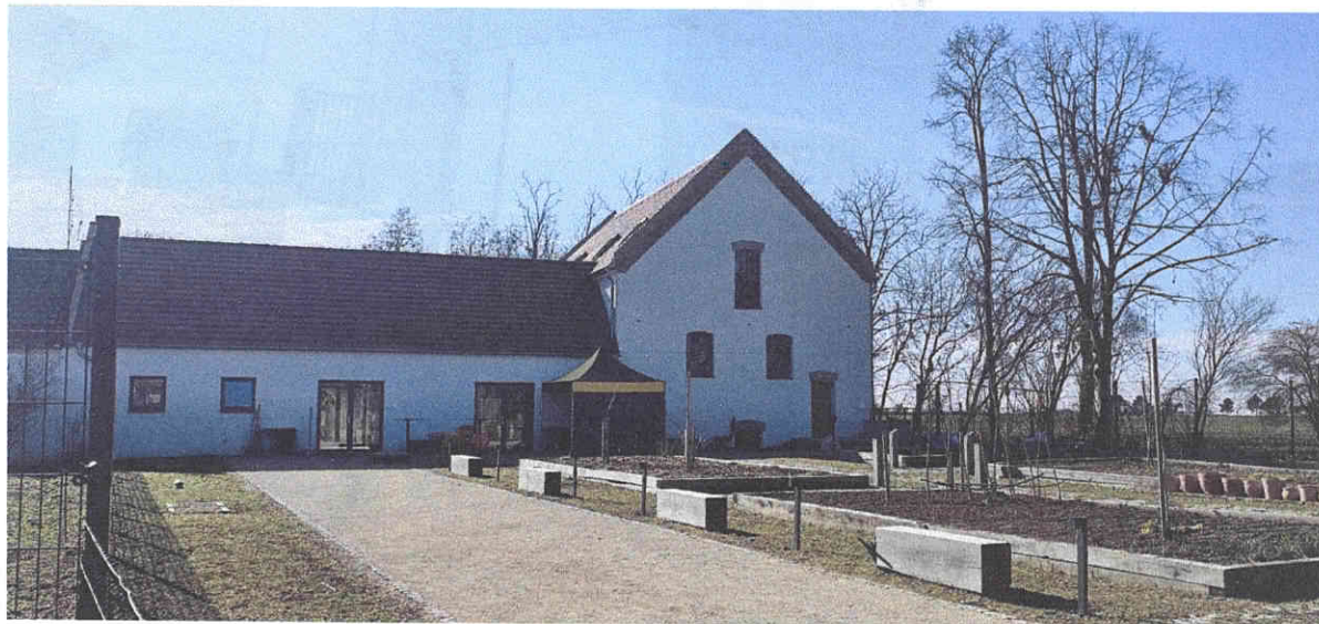
Obr. 1 Archopark Cifer – Pác – elektroinštalačné práce
