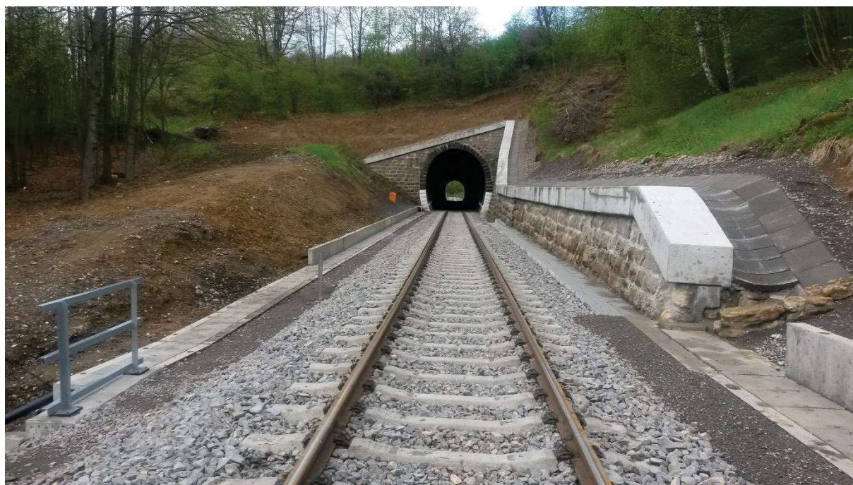
ŽSR, ŽST Prievidza-ŽST Handlová, rekonštrukcia k.č.1,k15,336-16,570-realizácia
