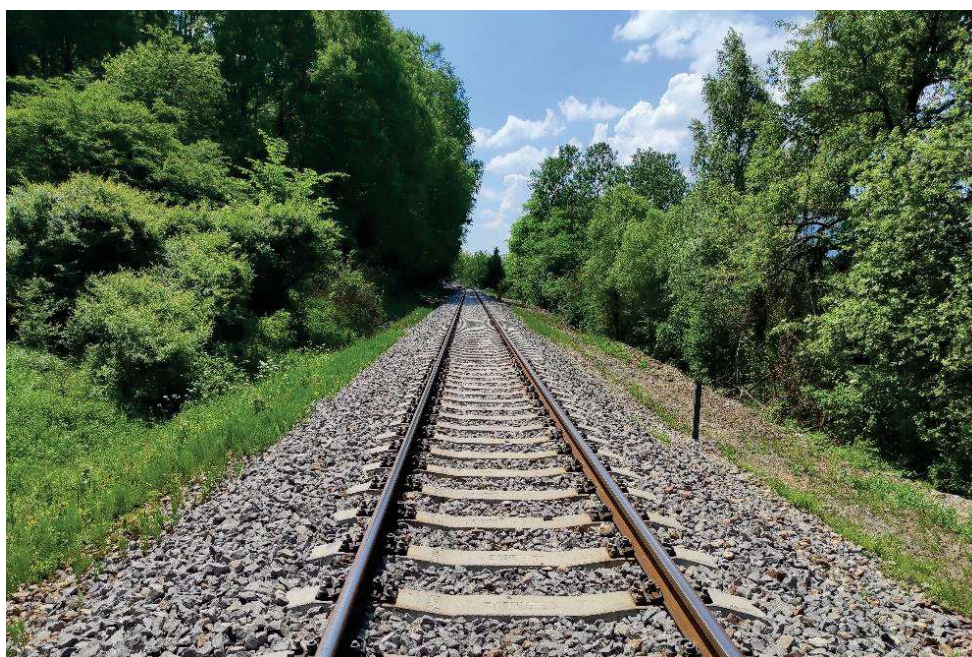
ŽSR, ŽST Prievidza-ŽST Handlová, rekonštrukcia k.č.1,k15,336-16,570-realizácia
