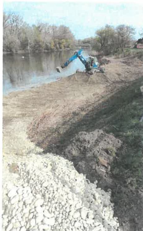
Úprava štrkovej lavice č. 1
