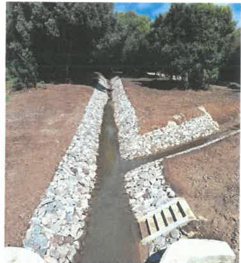
Úprava Branovského potoka a Hastrgáňa
