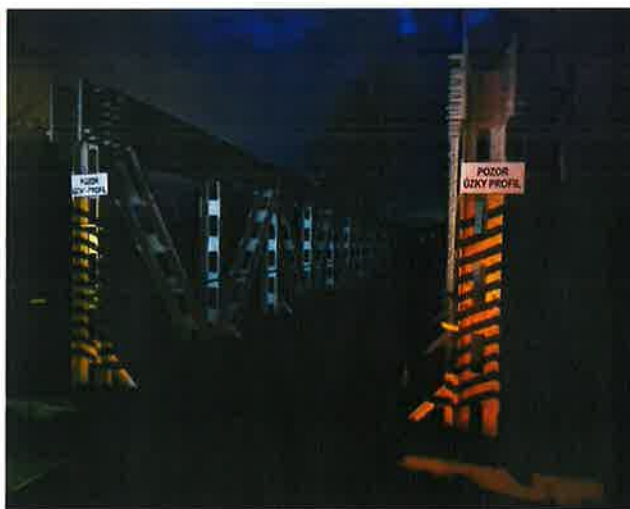
Železničný most v obci Vlkanová
