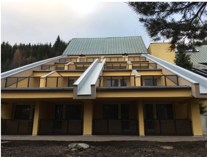
Hasičská zbrojnica, Obec Leštiny - Stavebné úpravy
