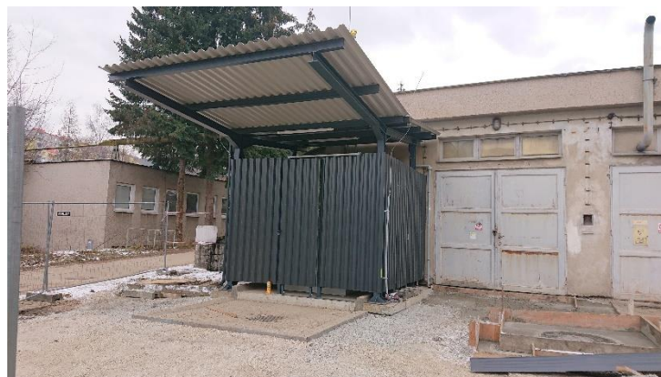
Výmena zásobníka nafty pre dieselagregát, DONsP Dolný Kubín – stavebné práce
