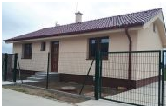
Dokončená stavba Javorina - bungalov
