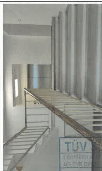
Rekonštrukcia bytovky DD a DSS, Veľký Krtíš, 2023
