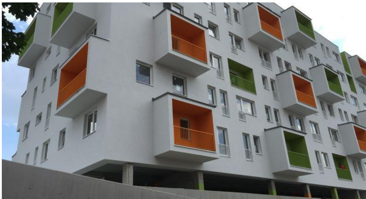
Zateplenie fasády Ivánska cesta, Bratislava - II. etapa
