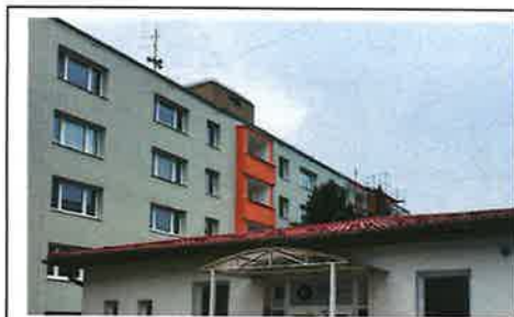
DD A DSS LUNA BREZNO - ZATEPLENIE OBJEKTU, 2024
