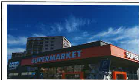
COOP JEDNOTA DETVA - REKONŠTRUKCIA FASÁDY, 2021
