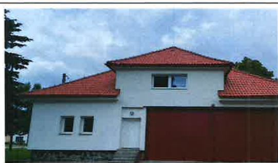
HASIČSKÁ ZBROJNICA DETVA - REKONŠTRUKCIA A MODERNIZÁCIA, 2020
