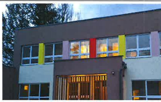
MŠ ZVOLEN PRACHATICKÁ – REKONŠTRUKCIA PAVILÓNU A, 2023
