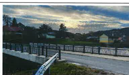
VÝSTAVBA NOVÉHO MOSTA, ČIERNY BALOG - KRÁM, 2018
