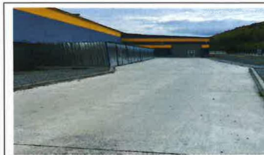
MICROSTEP HRIŇOVÁ BETÓNOVÁ PRÍSTUPOVÁ CESTA K HALE – VÝSTAVBA, 2019
