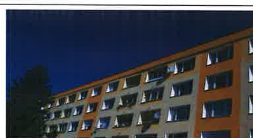
POLTÁR SKLÁRSKA UL., ZATEPLENIE OPLÁŠTENIA PANELOVÉHO DOMU, 2021
