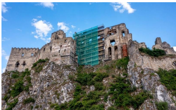
Hrad Beckov – Rekonštrukcia západného paláca
