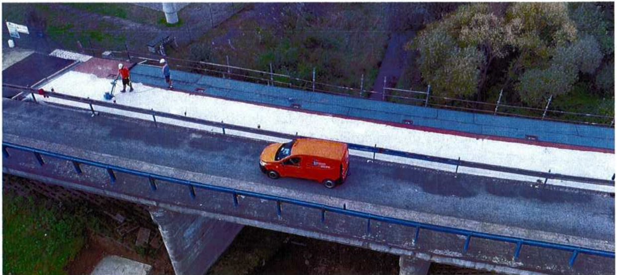
Rekonštrukcia ciest III/3541 a III/3586, Ladomírová
