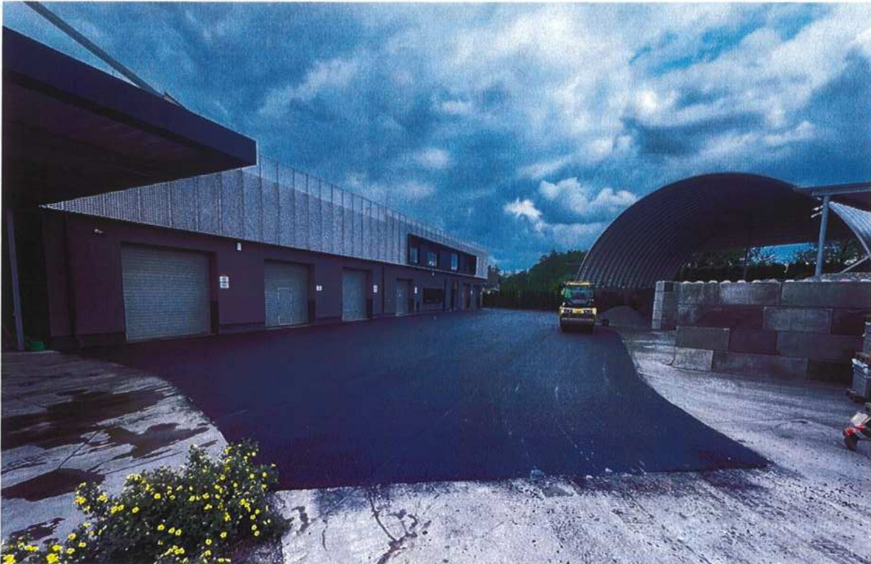
Úprava spevnených plôch - FENEGA Kračúnovce
