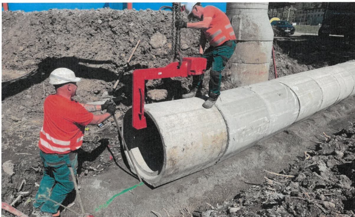
Obrázok 9 - Prenčov - kanalizácia a ČOV I. etapa
