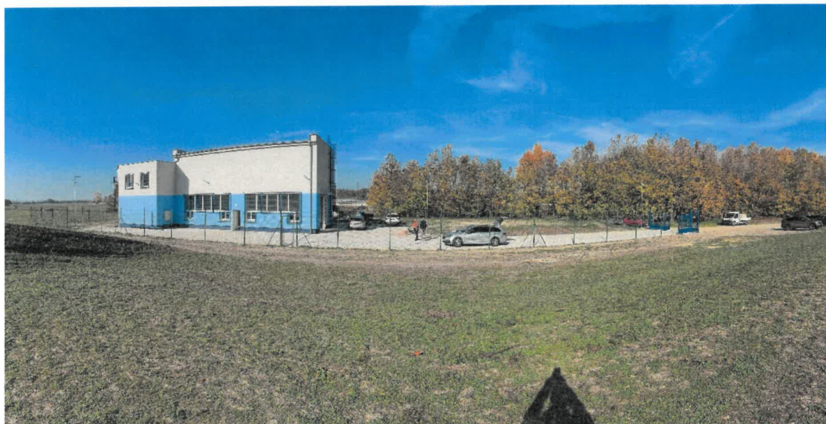
Obrázok 2 - Čenkov rekonštrukcia čerpacej stanice
