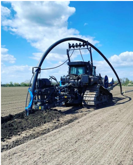
Pluhovanie káblov a potrubí
