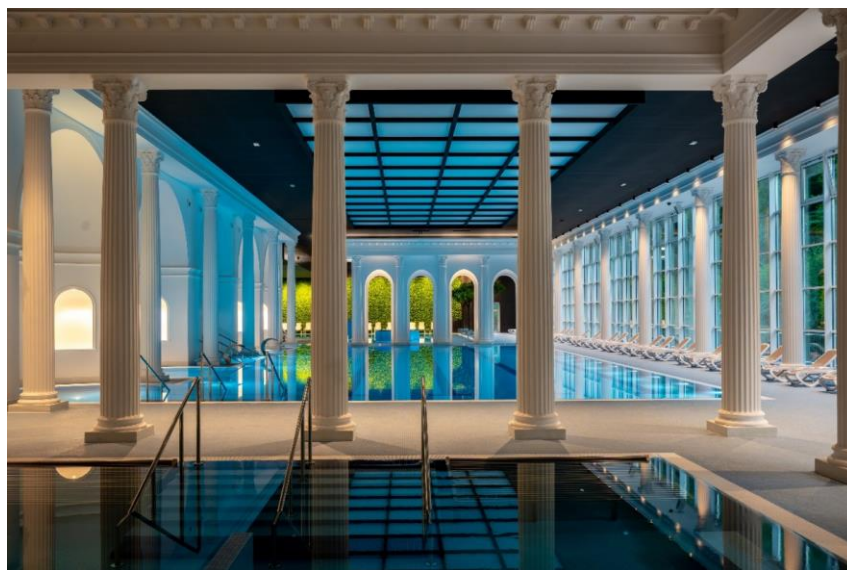
Kúpele Brusno – dokončenie bazénovej haly prístavby k objektu Poľana, Brusno.
