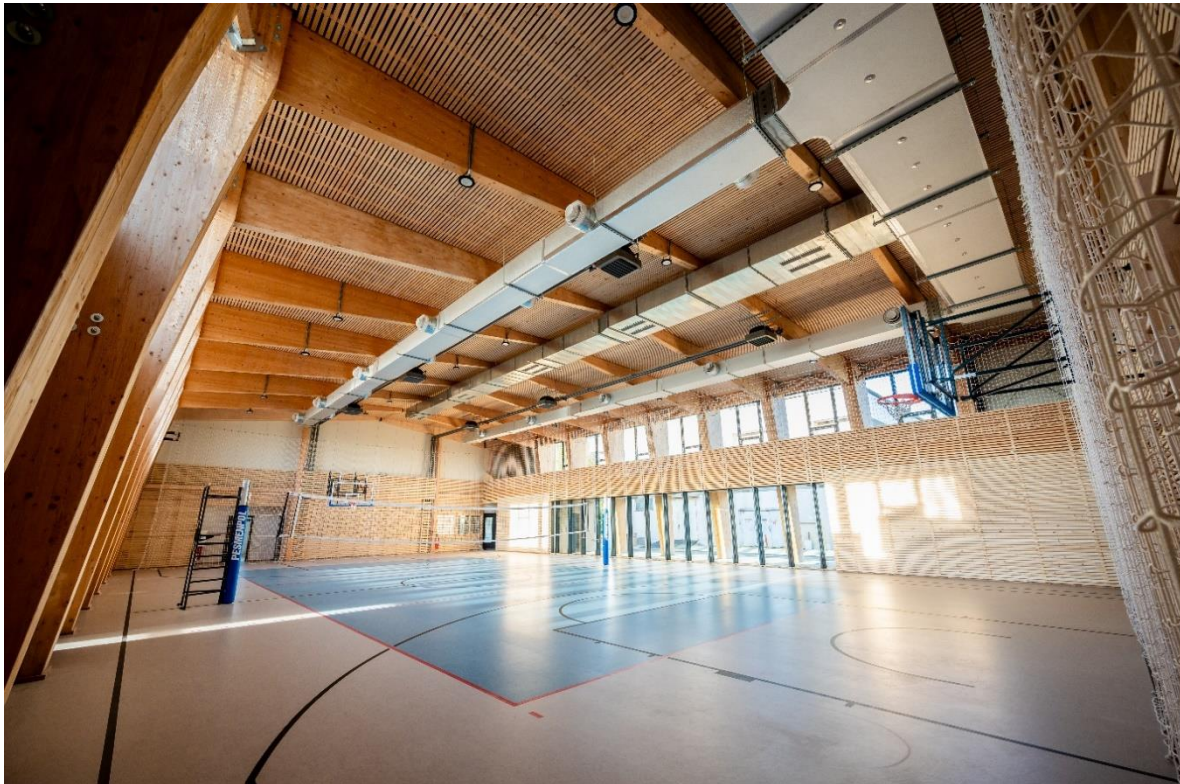
ZŠ s MŠ I. Krasku – novostavba telocvične, Trnava.
