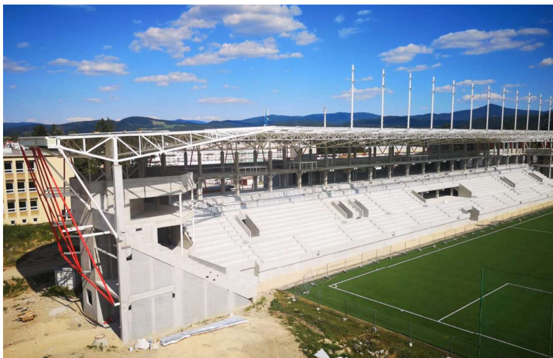
Výstavba futbalového štadióna v Trenčíne.
