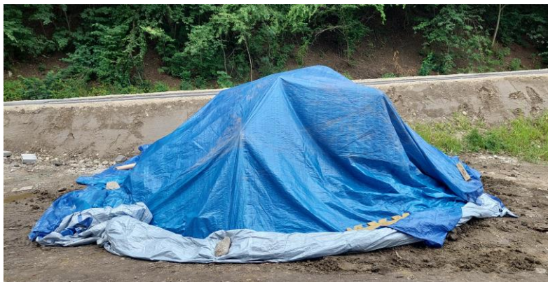
Dočasné uloženie kontaminovanej zeminu pred odvozom na zneškodnenie
