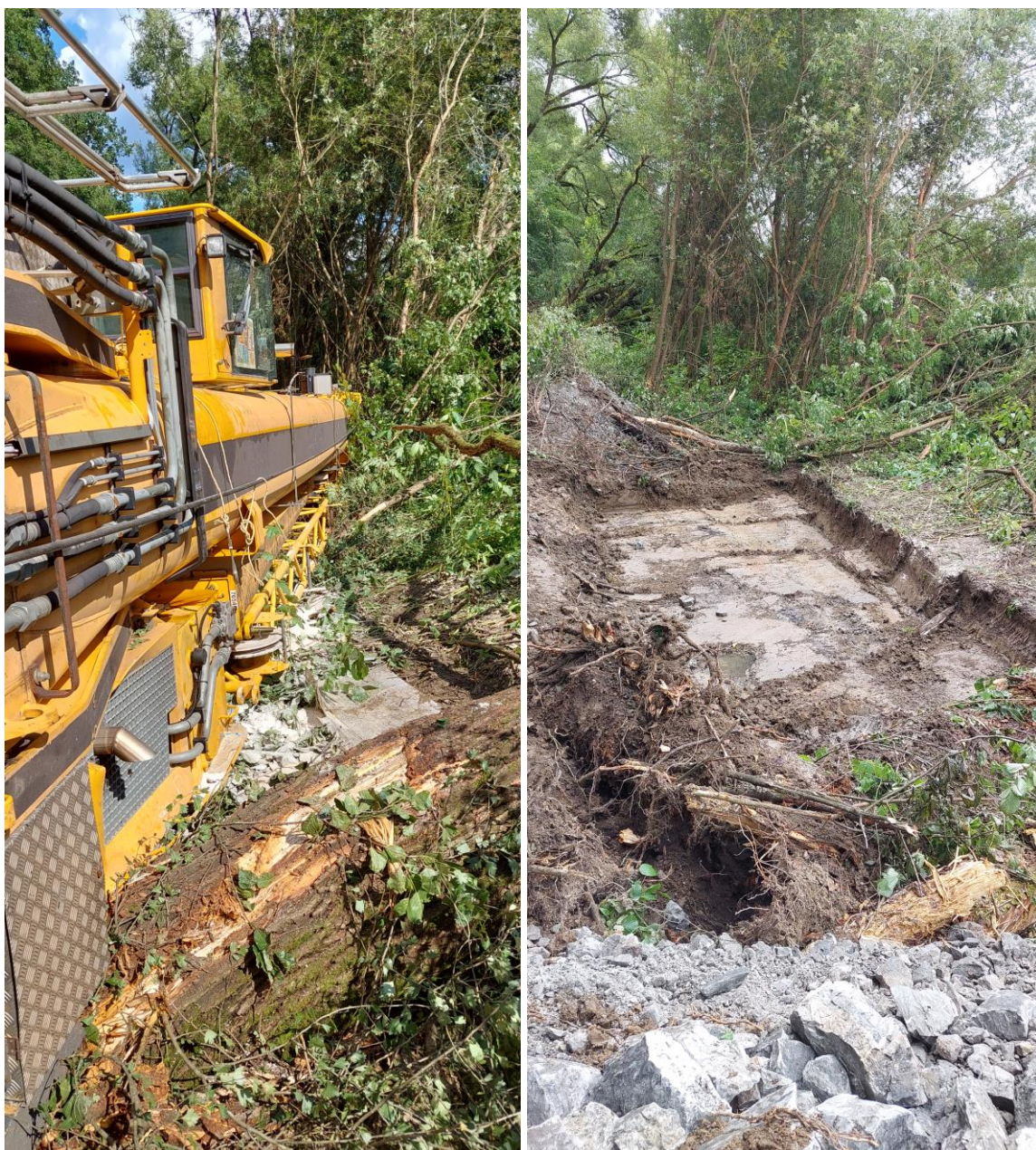
Posypanie kontaminovanej plochy sorbentom a odbagrovanie zeminy pod kontaminovanou plochou do hĺbky cca 30-40 cm.
