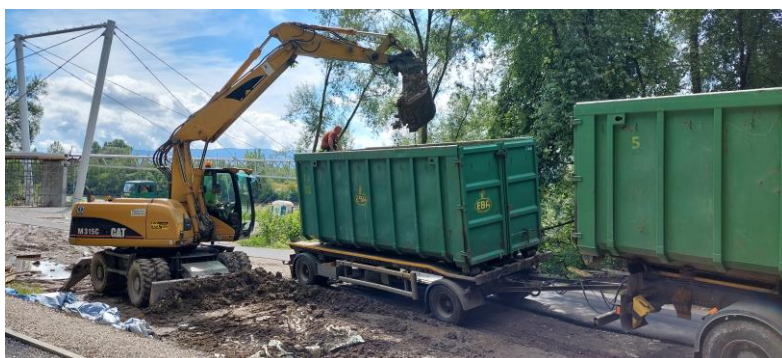
Naloženie kontaminovanej zeminu a odvoz na miesto zneškodnenia resp. biodegradácie
