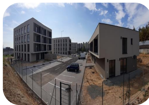
obytný súbor POVRAZY (OBYTNÁ ZÓNA POVRAZY 1. etapa) na ul. Jána Pavla II v Košiciach
