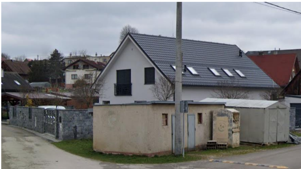
Budova v obci Brezany, kde spoločnosť FEROSTA vykonáva svoju činnosť.
