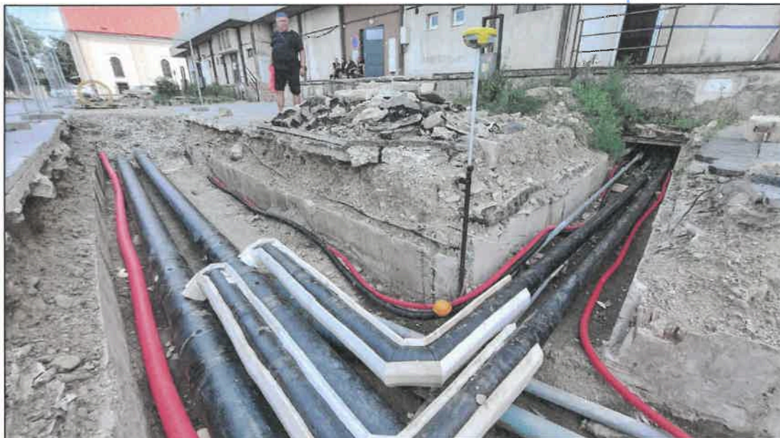
2022/2023 Bardejov rekonštrukcia rozvodov tepla
