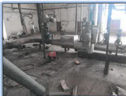
2022/23. Rekonštrukcia kotla K5
