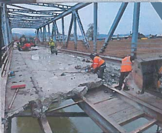
Obr. 9 Most Ilava cez Vážsky kanál
