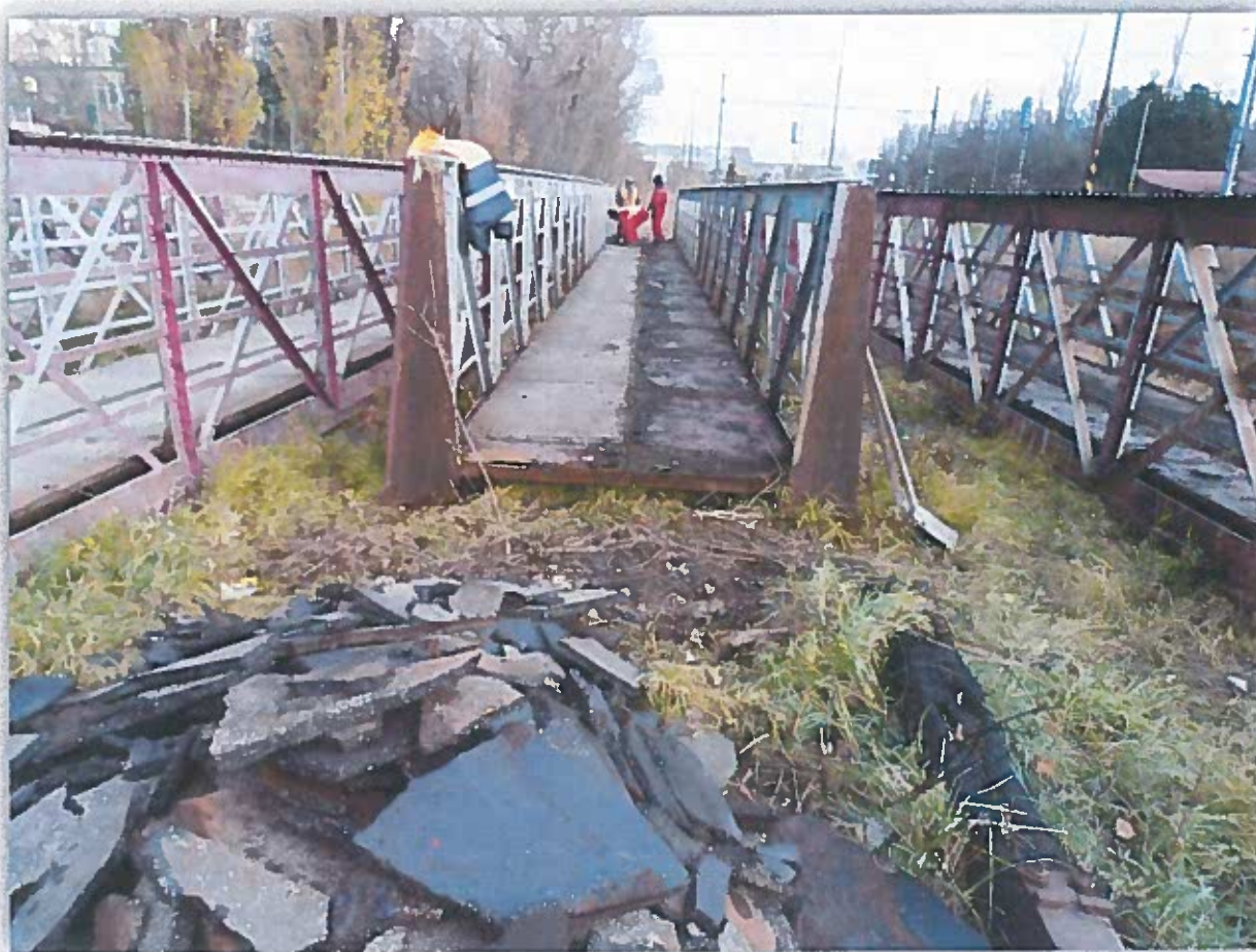
Obr. 7 Železnice-demontáž železničného nadjazdu pri PALME, Bratislava
