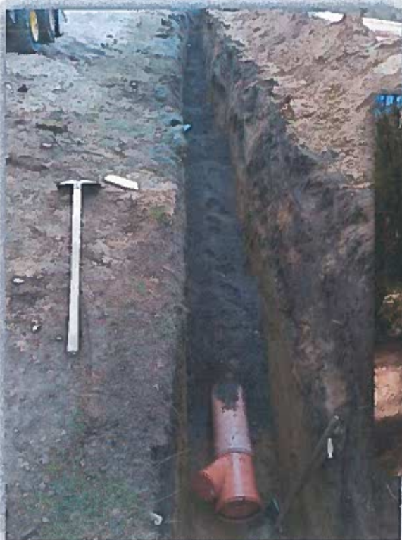
Obr. 10 Pata – rozšírenie verejnej kanalizácie
