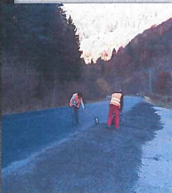
Obr. 6 Rekonštrukcia cesty II/583 k. ú. Párnica
