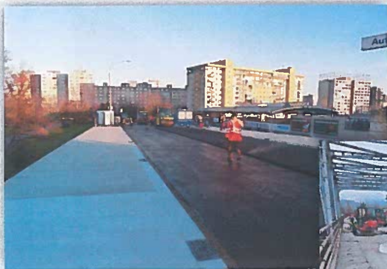
Obr. 8 Oprava mosta ev.č. M -095 nad Panónskou cestou-nadjazd k Budatínskej ulici v Petržalke, Bratislava
