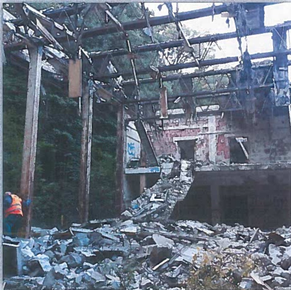
Obr. 12 Odstránenie stavby Snežienka, Bratislava
