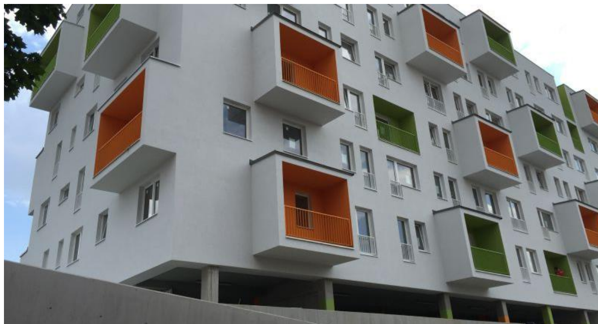
Zateplenie fasády Ivánska cesta, Bratislava - II. etapa
